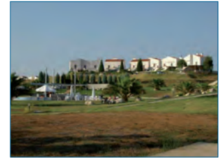
Ferienhausanlage / Holiday resort - (GR) Gewerbliche Kläranlage 80 EW / Industrial WWTP 80 PT
