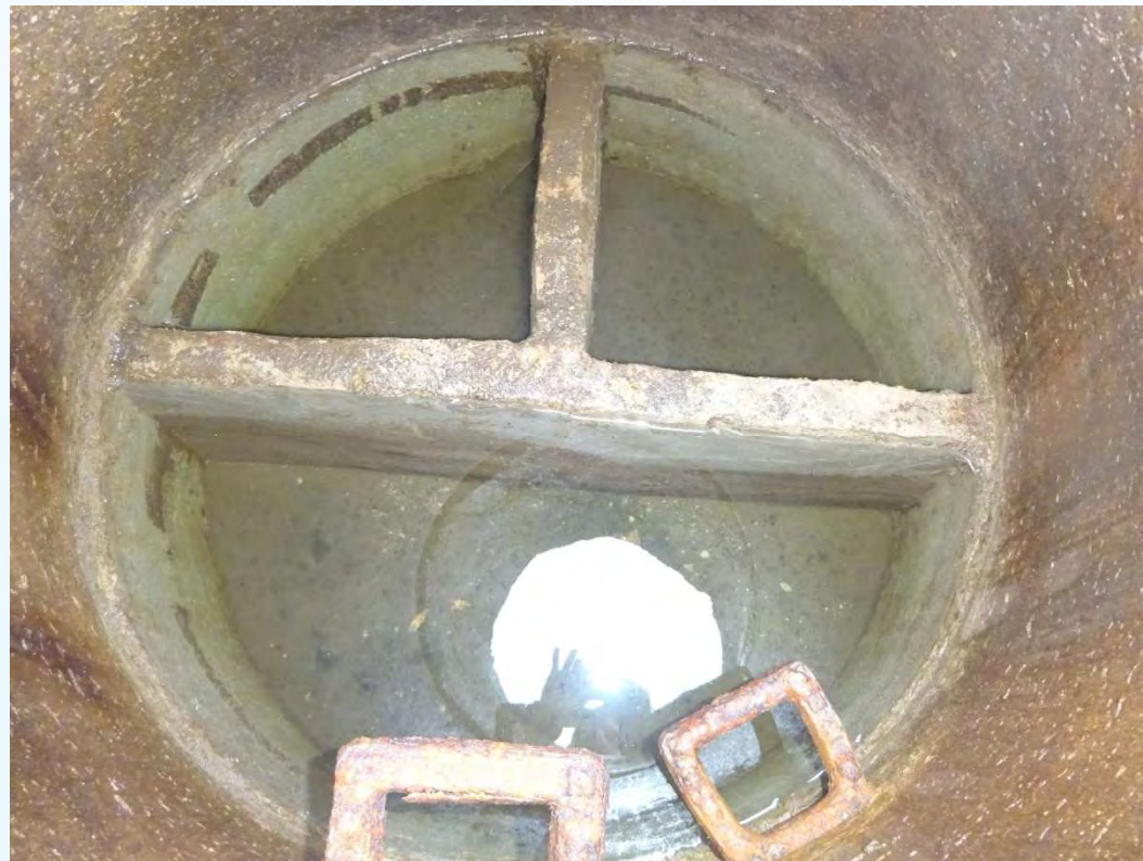
Dreikammergrube ohne Funktion (kein Zu- und Ablauf, keine Verbindung zwischen Kammern)
