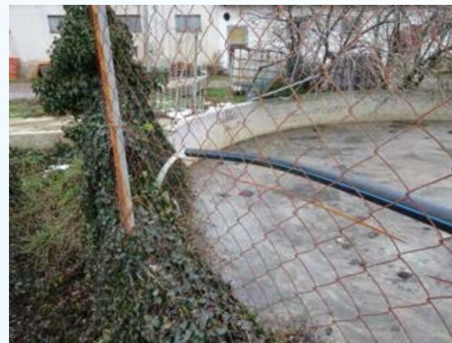
Einleitung Abwasser in Güllegrube Folie 38
