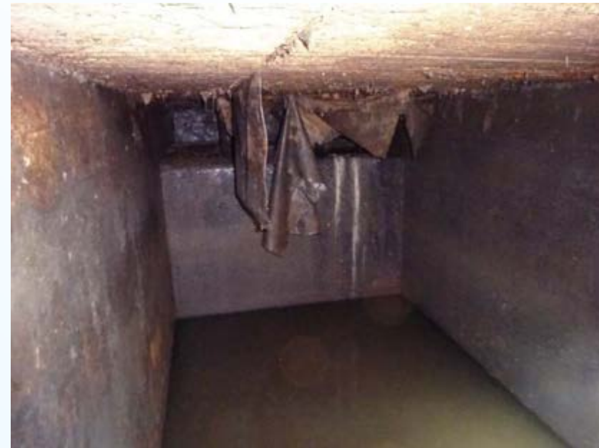
Abflusslose Grube ohne Fäkalschlamm
